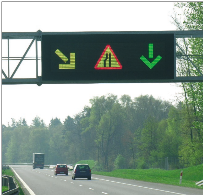
Znak zmiennej treści wykonany w technologii RGB. Autostrada A4 (Nogowczyce 276,7 km), jezdnia południowa. Zdjęcia dzięki uprzejmości TRAX elektronik.
